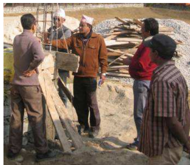
Ramesh Chitrakar (l.) bei der Bauaufsicht durch Fachleute.
