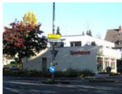
Der neue Geschäftsraum liegt über der Sparkassenzweigstelle im ersten Stock.
