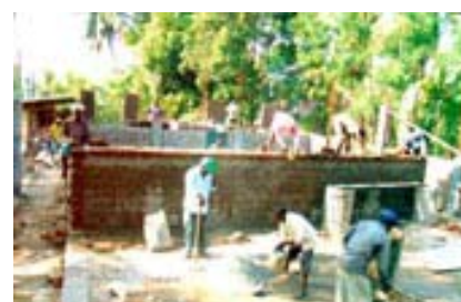
Im Oktober war man mit der Errichtung des Erdgeschosses beschäftigt.
