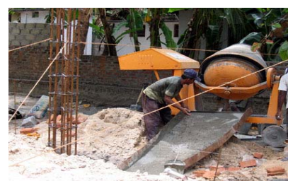
Nach der feierlichen Grundsteinlegung wurden solide Fundamente gelegt, die später das zweigeschossige Gebäude tragen werden.
