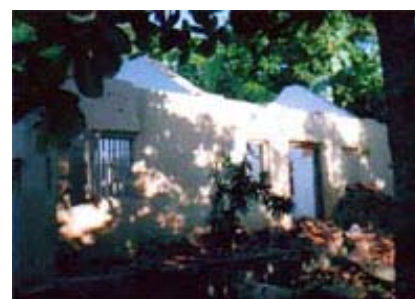
Das alte Gebäude vor dem Abriss
