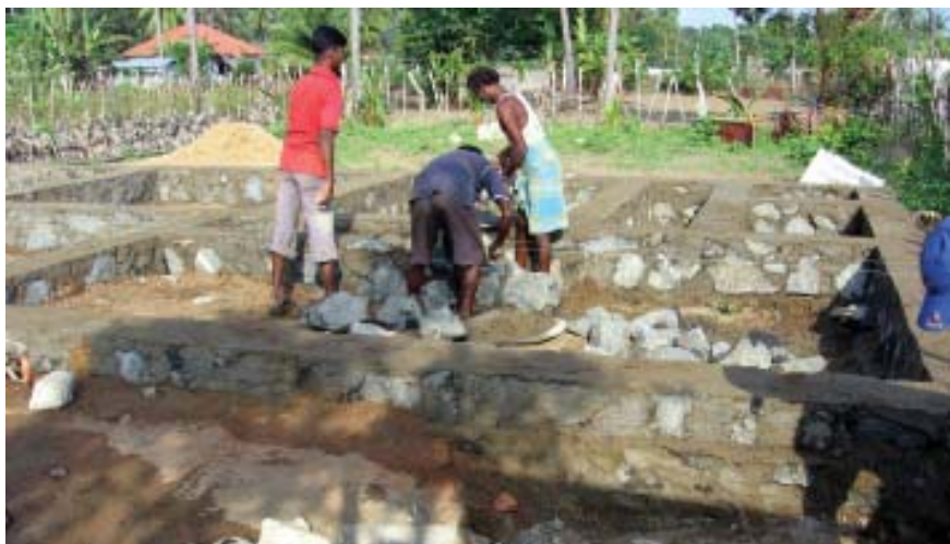
Die Familie erstellt das Fundament des neuen Hauses in Eigenleistung. Das zukünftige Haus besteht weitgehend aus Fertigbauteilen, die man aus Indien importiert.
