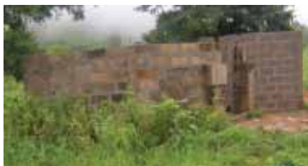
Der Rohbau der neuen Schülertoilette.
