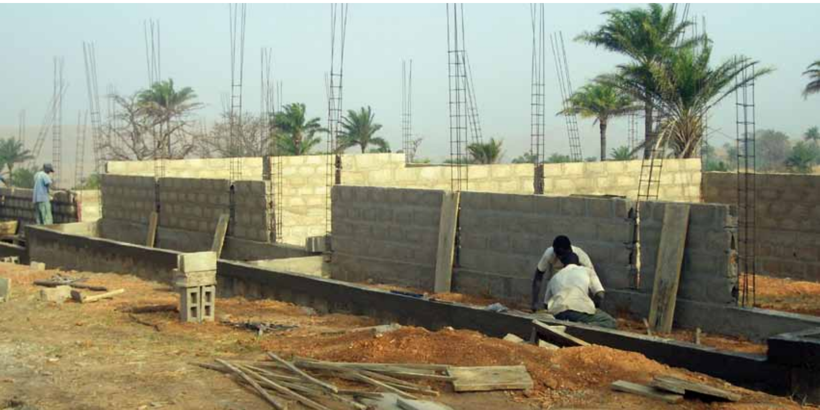
Schon im Herbst 2008 begann man mit der Bautätigkeit für die neue weiterführende Schule
