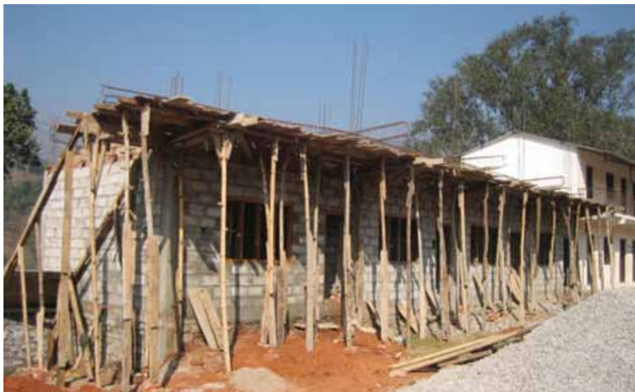
Der Rohbau der Sanskrit Secondary School steht.
