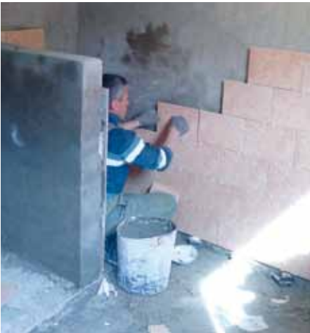
Eigenleistung ist die Devise auch beim Verfliesen.
