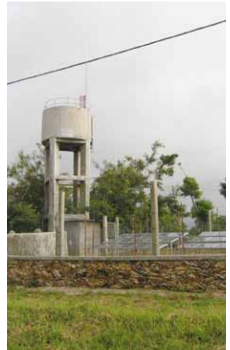
Die 2004 neu errichtete Wasserversorgungsanlage.
