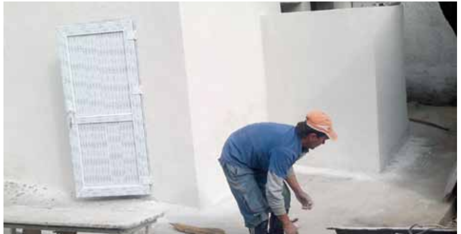
Die neu verputzte Toilettenanlage.
