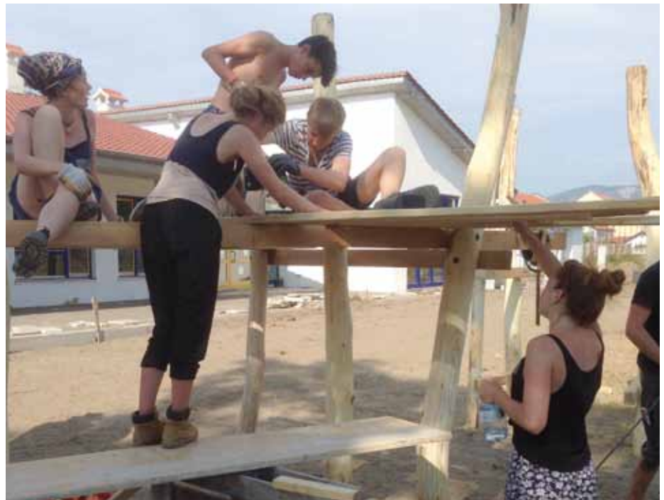
Ein Bautruppi bei der Arbeit.
