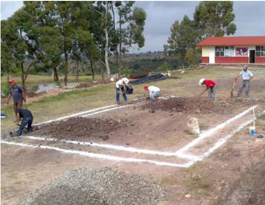
Gründungsarbeiten im vergangenen Herbst.
