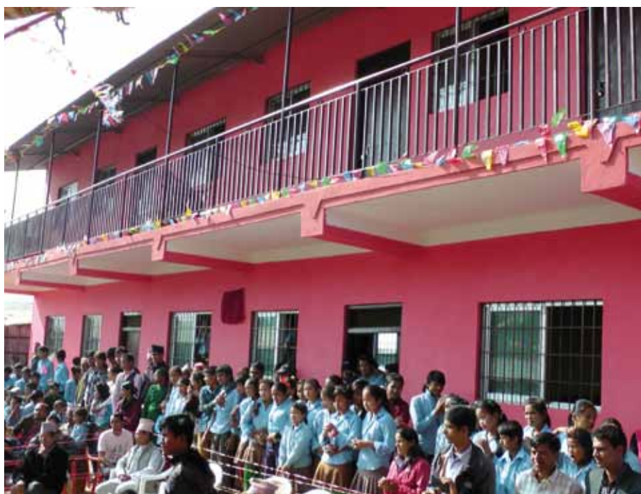
Einweihung der Malika-School nach Reparatur aller Schäden.
