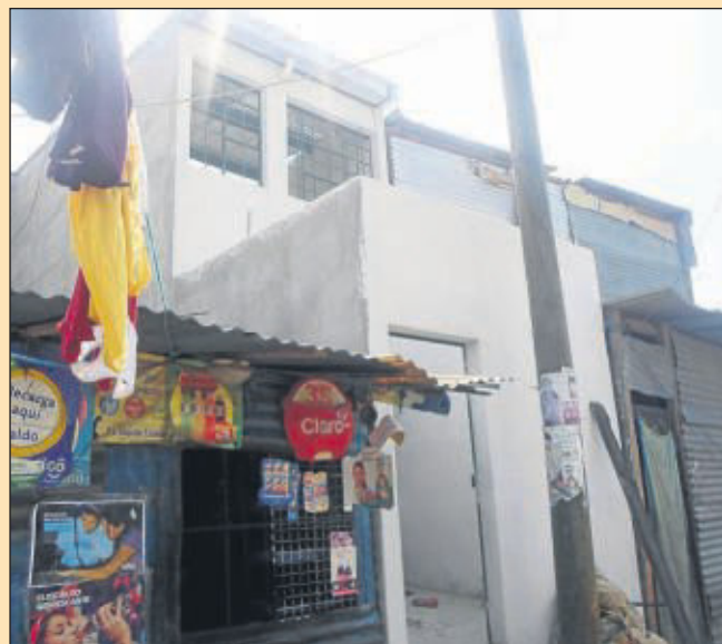
Die neue Kita – hier noch im Rohbau – beendet für einige Kinder das tägliche Eingesperrt-Sein und bietet einen ganz neuen Austausch.
