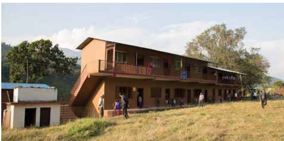
Das Wellblechdach der Sanskrit-Schule soll eine Dämmung bekommen.
