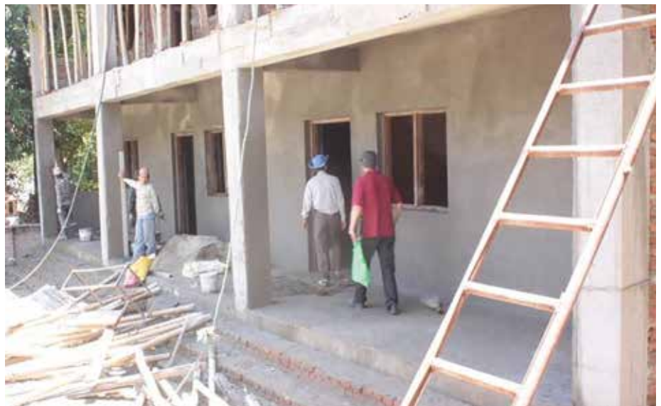
Der Bau der Ranabhubaneshwori-Schule schreitet gut voran.
