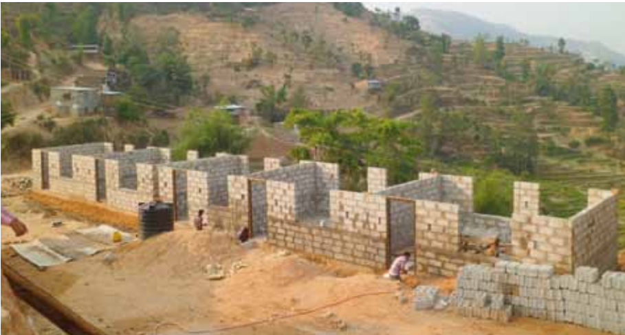
Die „Feldhaus-Classrooms“ sind im Rohbau fast fertiggestellt.
