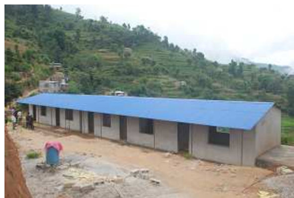
Schulgebäude und 3 fertige Räume im "Feldhaus Block"
