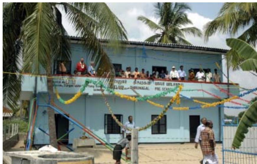
Blick auf den neu errichteten Kindergarten in Veloor, der nun für 25 Kinder Platz bietet. Für die Inneneinrichtung muss allerdings noch einiges getan werden.
