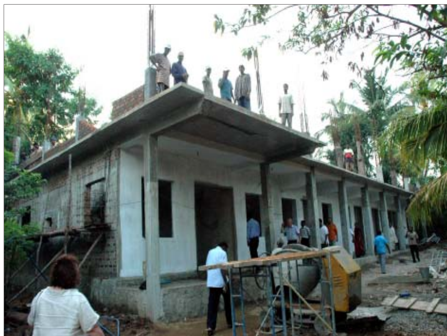
Der Erweiterungsbau des Waisenhauses besitzt mit 30 m Länge eine beachtliche Größe. Die kräftigen Fundamente erlauben einen Ausbau von bis zu drei Stockwerken.
