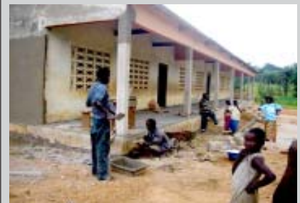
Renovierungsarbeiten an der Schule
