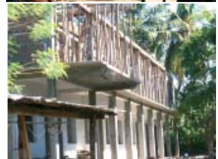
Die Fotos zeigen, dass am Neubau des Waisenhauses fleißig gearbeitet wird.
