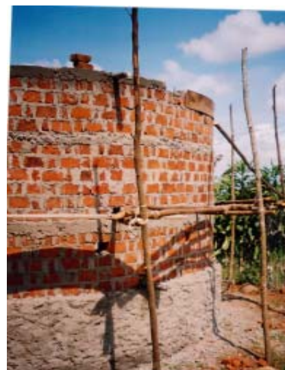
Die Zisterne in der Rohbauphase.
