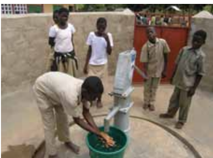
Eine Wasserpumpe fördert kühles, frisches Wasser aus großer Tiefe.
