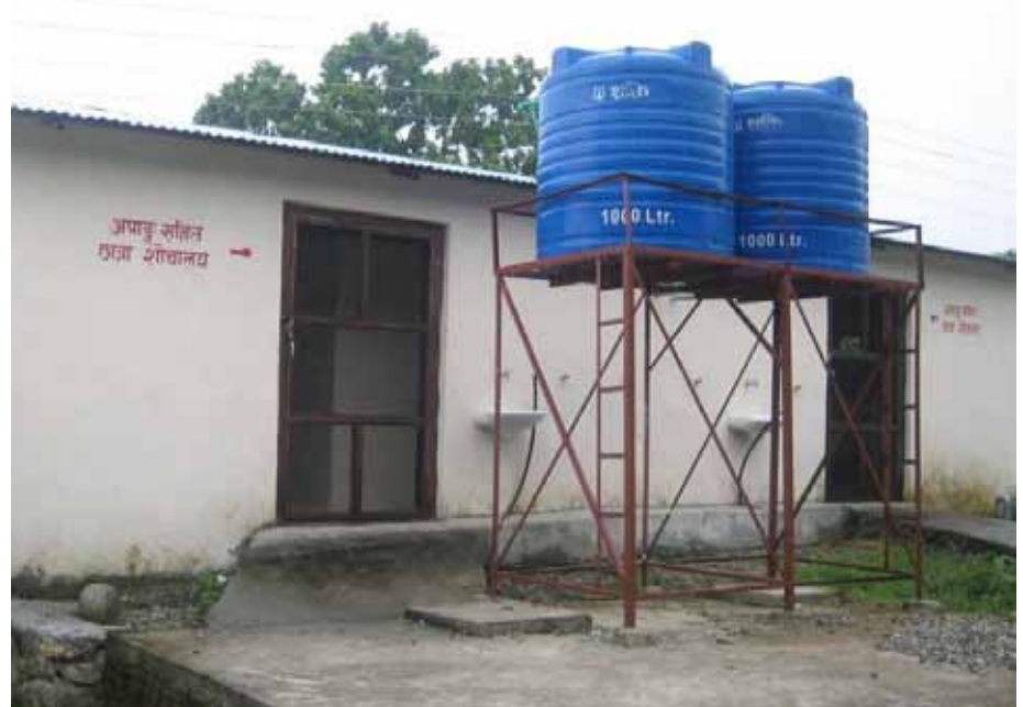
Die neue Toilettenanlage.
