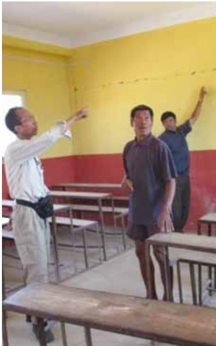
Ramesh Chitrakar begutachtet Risse im Schulneubau.
