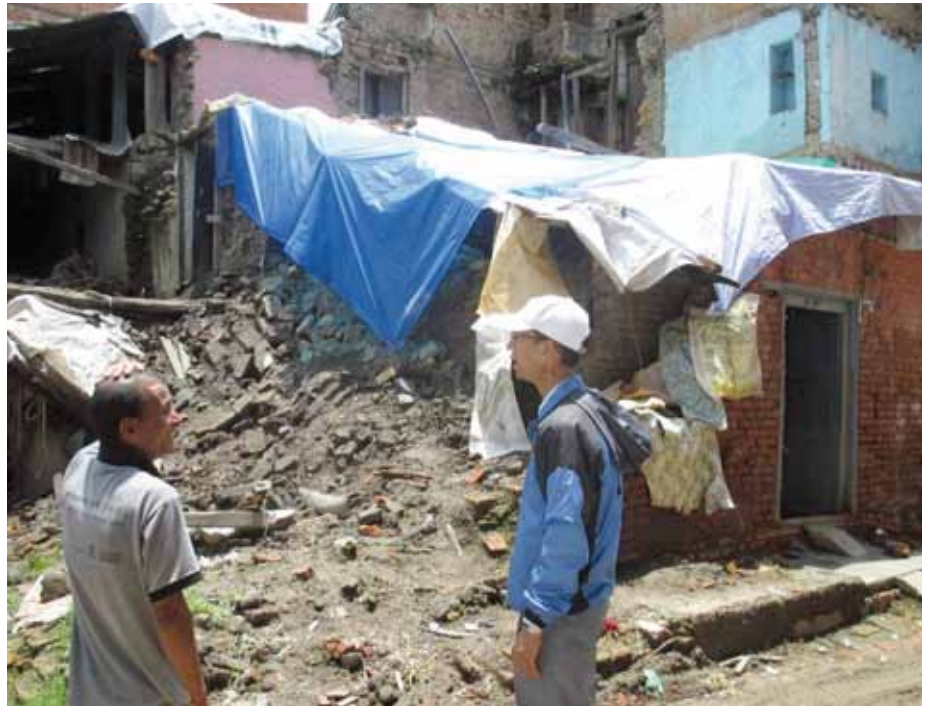
Viele Häuser sind irreparabel.
