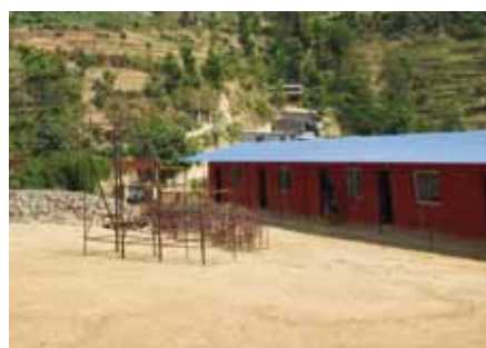
Der Schulneubau in Duipipal ist weitgehend unversehrt geblieben...
