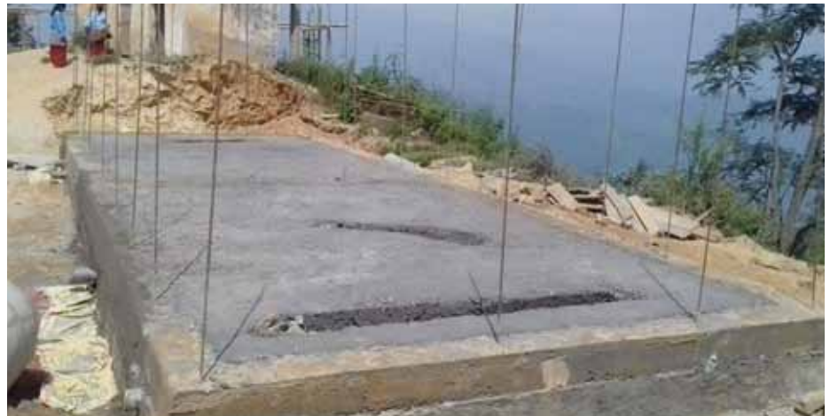
Die Fundamente der Toilettenanlage in Duipipal sind fertiggestellt.
