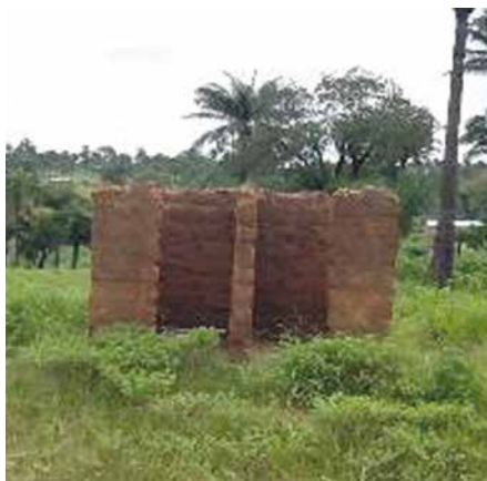
Die frühere provisorische Toilette.
