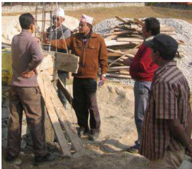
Ramesh Chitrakar (l.) bei der Bauaufsicht
