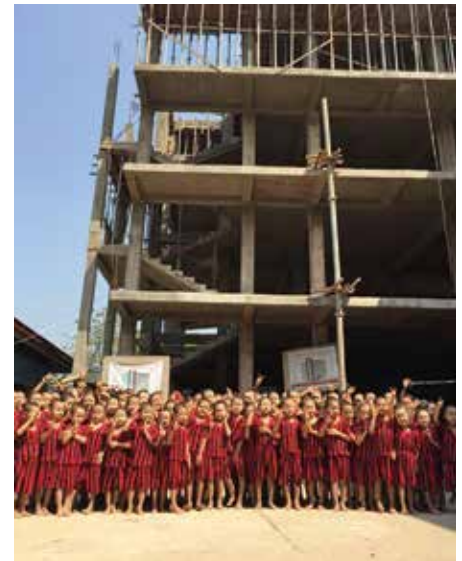
Rohbau des Waisenhauses.
