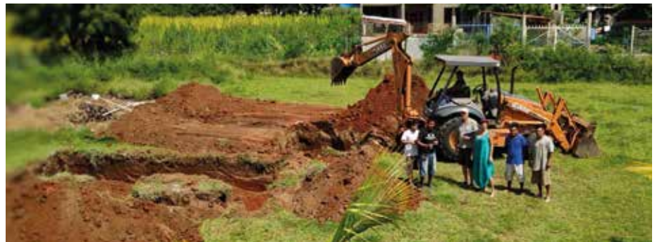
Die Baugrube ist ausgehoben.
