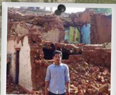
Große Zerstörungen nach dem Erdbeben 2015.
