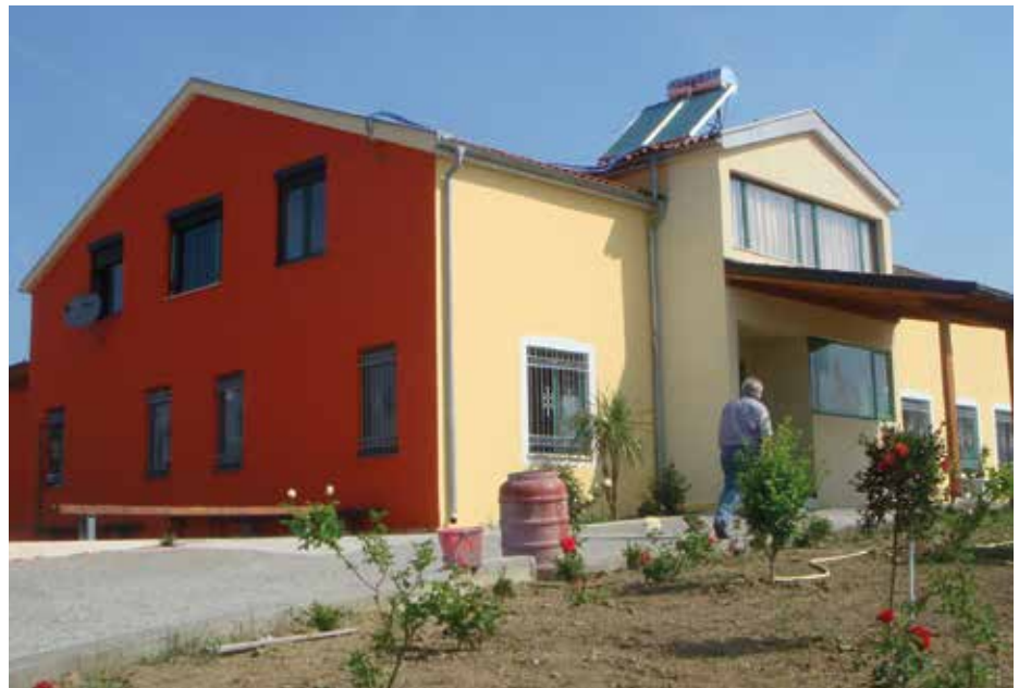
Ein völliger Kita-Neubau wurde in Gomsice errichtet.
