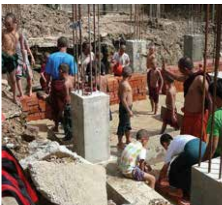
Rohbauarbeiten am neuen Waisenhaus in Yangon.
