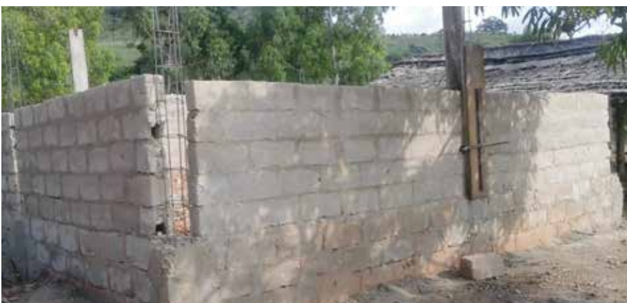
Der Umbau der Schule zur Vorschulklasse hat begonnen.
