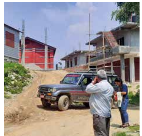
Die Außenanlagen werden bis zum Schulbeginn fertiggestellt sein.
