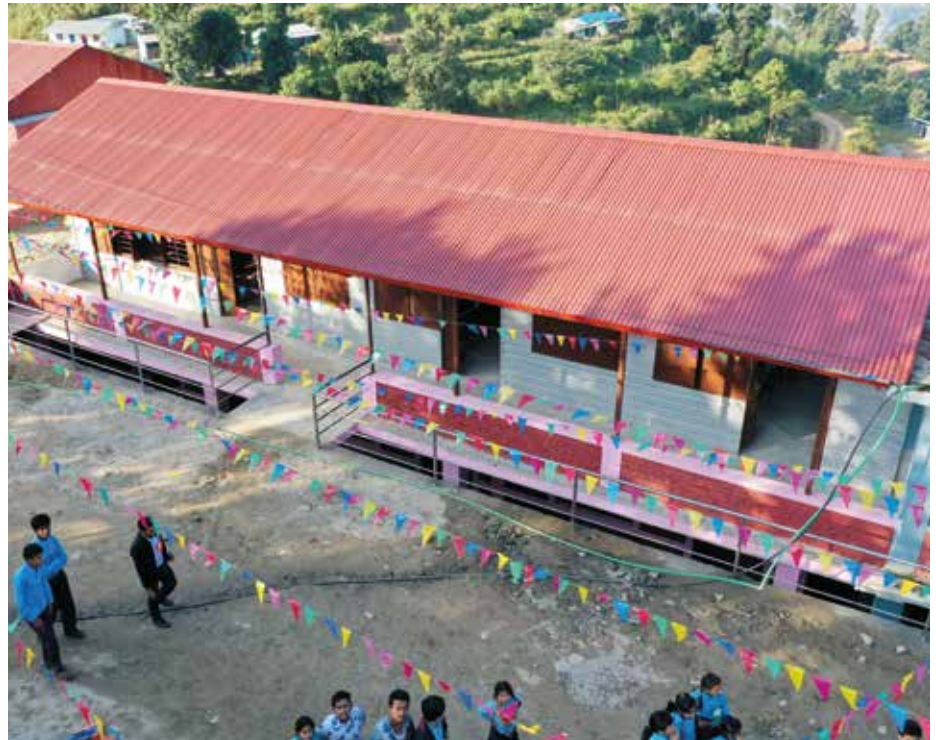
Neubau der Niranjana High School mit 8 Klassenräumen.
