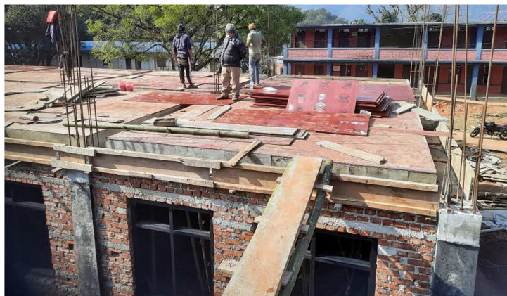
Abbildung 8: Schalung für Balken und Decke im ersten Stock
