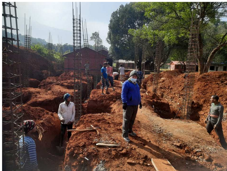
Abbildung 1: Auslegen des Fundaments und der Gräben
