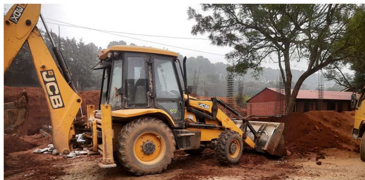
Abbildung 2: Entfernung von überschüssigem Boden vom Standort
