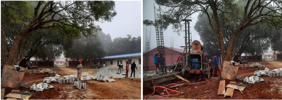
Abbildung 3: Erstellen der Bodenplatte
