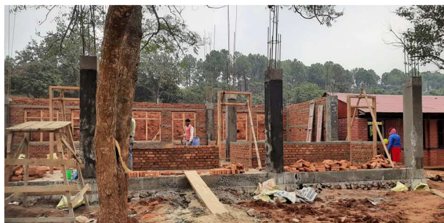
Abbildung 5: Einbau von Wänden, Türen und Fenstern im Erdgeschoss
