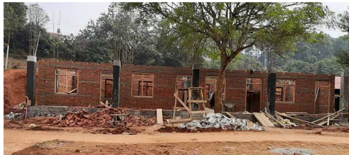
Abbildung 7: Nahezu vollständige Grundstruktur des Erdgeschosses
