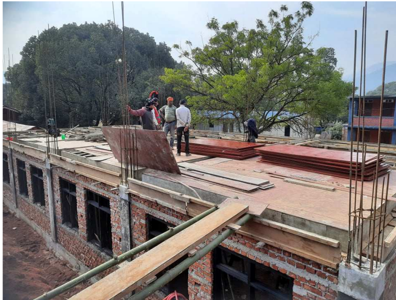
Abbildung 9: Verlegen von Brammenschalungen
