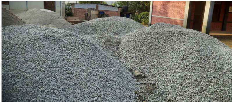
Bild 10: Alle Materialien zum Betonieren stehen vor Ort für die Decken- und Balkenbetonung bereit
