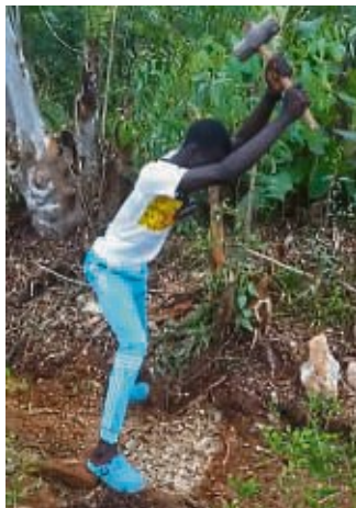
Der Weg zur Krankenstation wird gepflastert.
