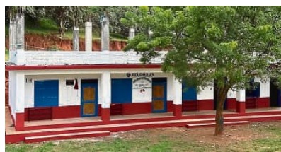
Das neue Schulgebäude ist auch äußerlich fest mit dem Namen Feldhaus verbunden
