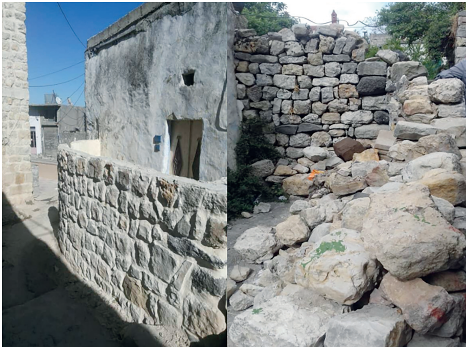
Eine Hauswand in Al Quadmus nach und vor der Instandsetzung.
