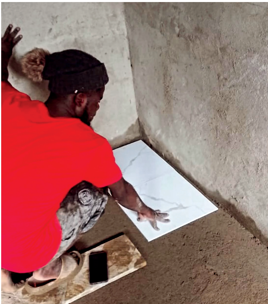
Beim Fliesenlegen kommt es gerade bei der ersten Reihe auf Genauigkeit an.
